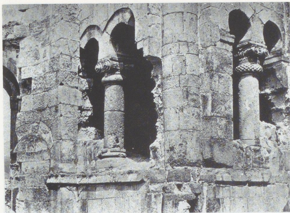
Fig. 6. Bana, pilier nord-est du X e siècle, chapiteaux du VII e réutilisés.
