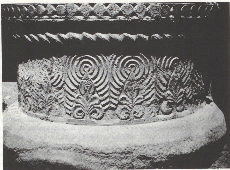
24. Pilier sud-est, base, détail.
