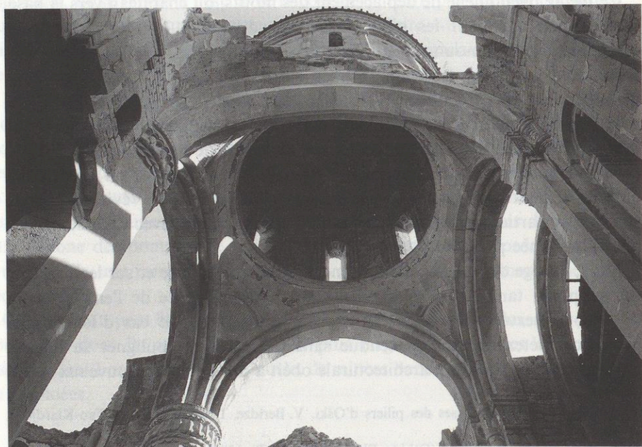
25. Construction de la coupole, vue du nord.
