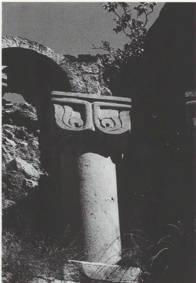
16. Galerie nord, fenêtre bilobée vers l'abside, détail, chapiteau.
