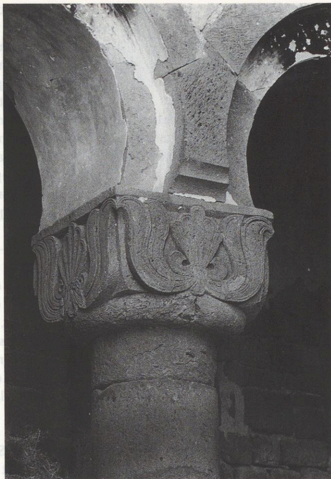
6. Chapiteau central sud.
