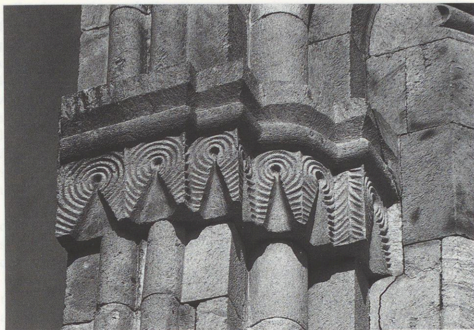
27. Façade ouest, arcade aveugle tripartie, détail, chapiteaux
