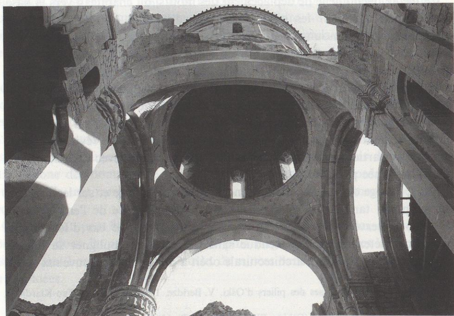
25. Construction de la coupole, vue du nord.
