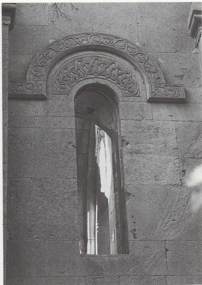
37. Fenêtre droite du transept nord.
