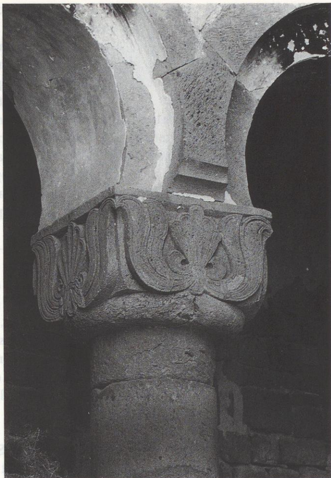
6. Chapiteau central sud.
