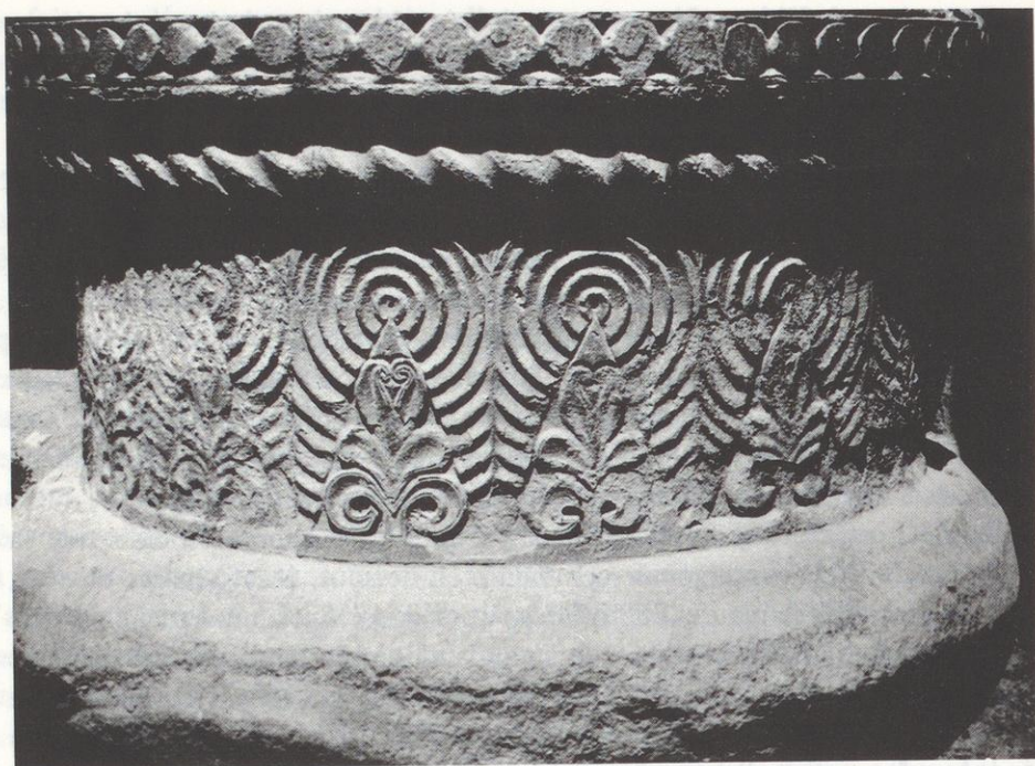
24. Pilier sud-est, base, détail.
