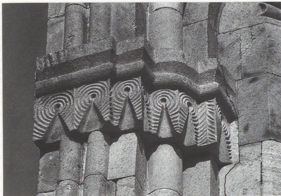
27. Façade ouest, arcade aveugle tripartie, détail, chapiteaux
