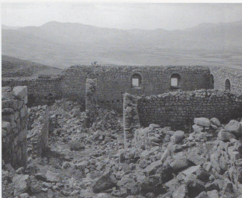
Abb. 18: Klosterhof, nördlicher Abschnitt mit Spuren baulicher Anlagen, Blick nach Westen
