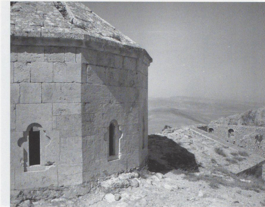
Abb. 10: Klosterkirche, Teilansicht Tambour, Blick von Südosten
