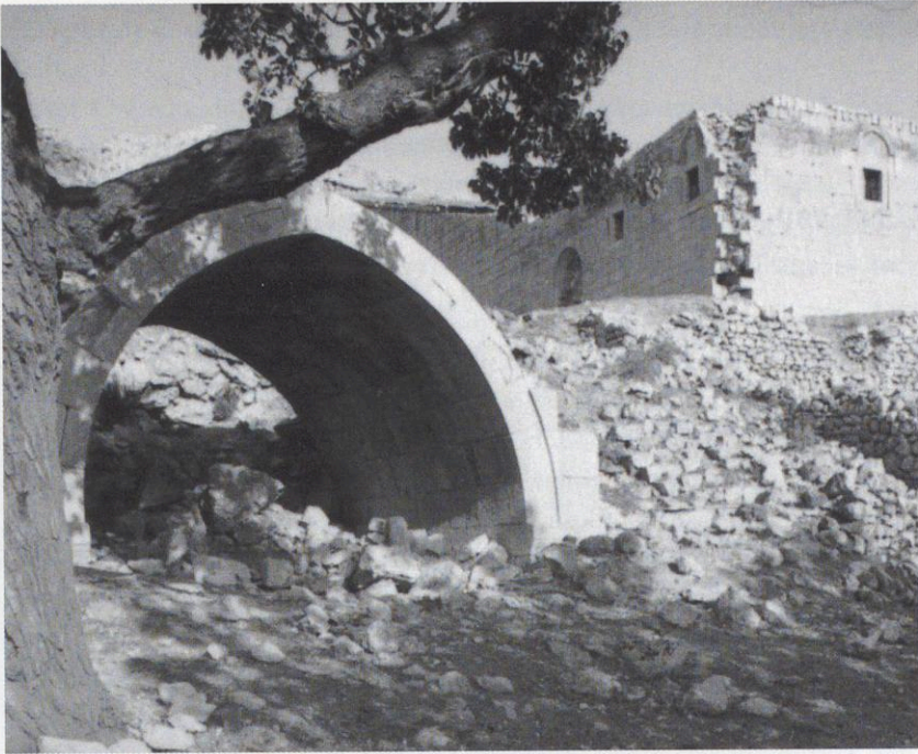
Abb. 26: Brunnenanlage [?] an der Nordwestecke der Umfassungsmauer, Ansicht von Westen
